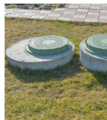
Einlassöffnungen von Wassertanks
